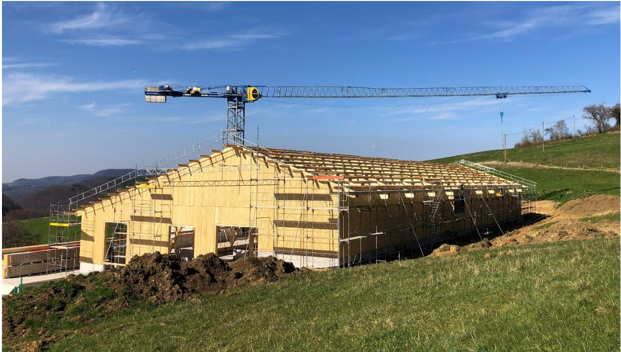
Besichtigung Neubau in Realisierung anlässlich der Baufachtagung N-W-CH, Quelle: AGRIDEA
