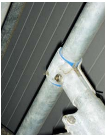
La pose de manchons en plastique aux points de croisement des conduites garantit un effet isolateur.
