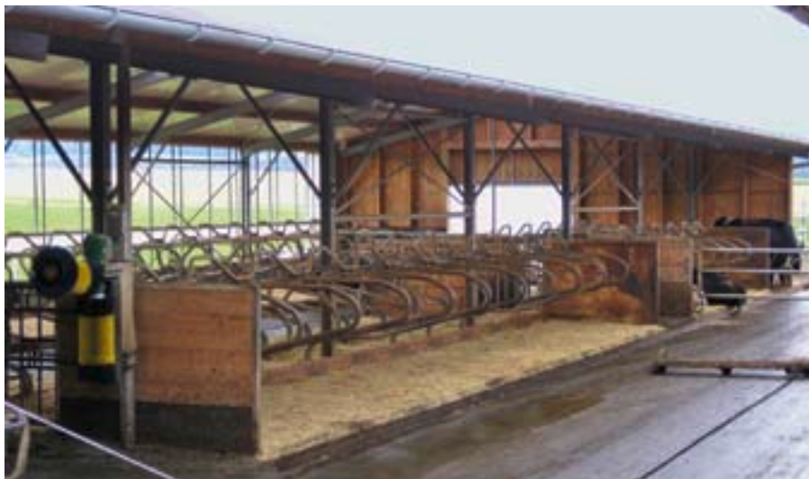
Ce type de construction légère ouverte avec de grandes travées peut, surtout lors de conditions extrêmes, menacer la charge limite de la statique. (Photos: Christian Guler)
